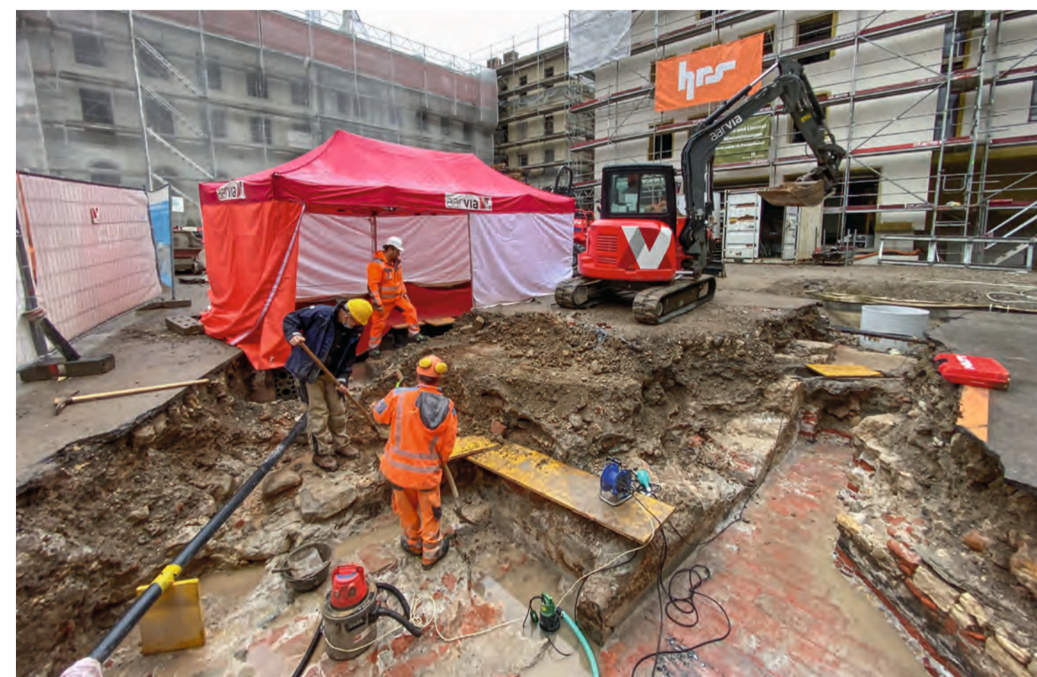
Bau- und Ausgrabungsarbeiten im Gleichschritt: Im Vordergrund liegt der Tonplattenboden des neuzeitlichen Bades offen. In der Bildmitte deutet die Mauer den westlichen Abschluss des Freibades an.
