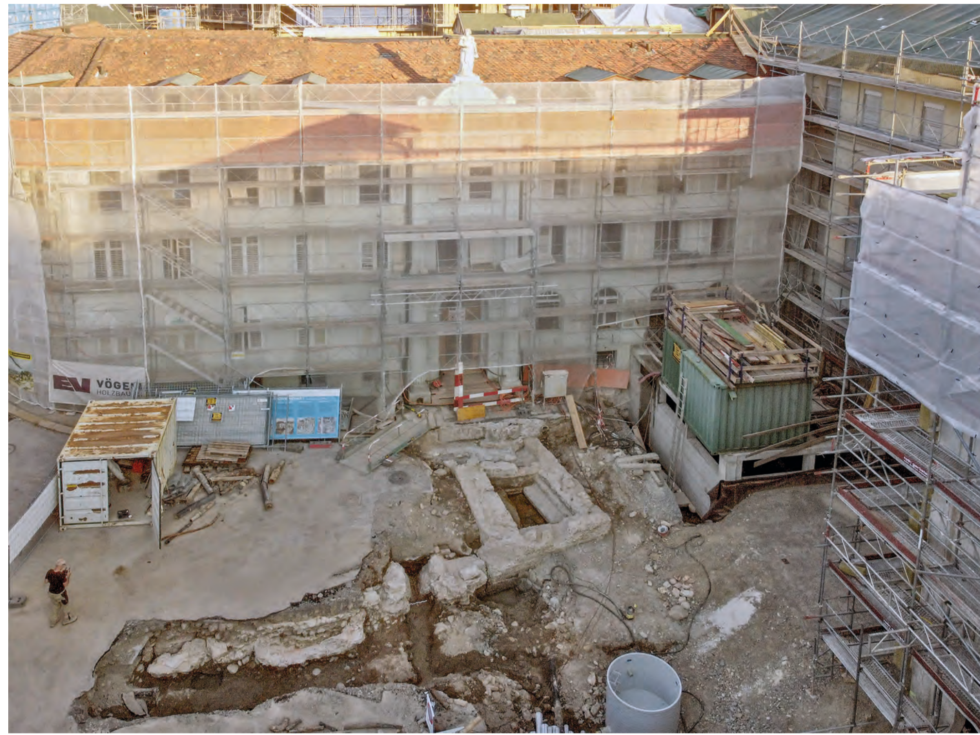
Blick auf den Kurplatz mit dem Verena Hof im Hintergrund: Vor dem Eingang in den Verena Hof ist in der Baugrube der nordöstliche Abschluss des Verena bades zu sehen.
