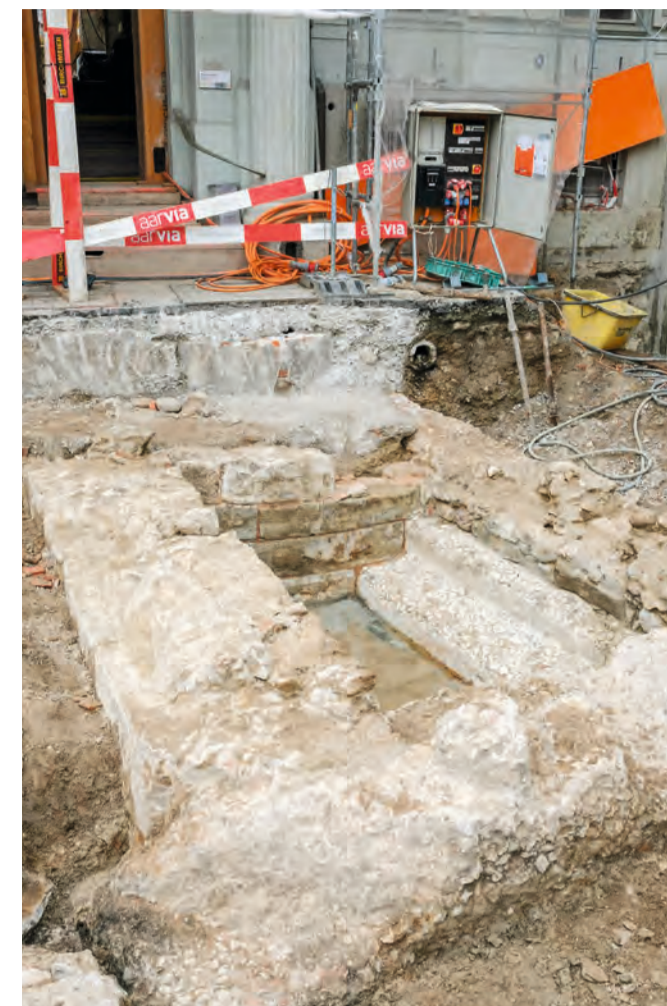
Nordöstliche Ecke des Verena bades: Am Beckenrand sind eine Einstiegs- und eine Sitzstufe sichtbar. Das Mauerwerk ist in Kalkmörtel gegossen und oberflächlich mit geschliffenen Kalksteinplättchen verkleidet. Am oberen Bildabschluss schliesst die runde Fassung der Wälderhutquelle an.
